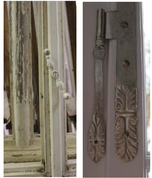
Links die sanierungsbedürftigen Rahmen mit Beschlag, rechts das perfekte Ergebnis nach der Bearbeitung.
